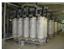
AVANT TRAVAUX : modules AC1125
