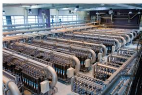
AVANT TRAVAUX modules HYDRACap® 60
