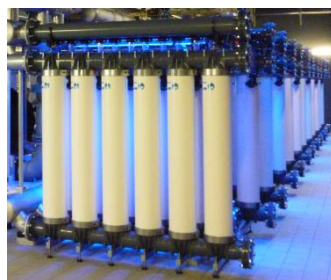
APRES TRAVAUX : modules ALTEON™-I-XL60
