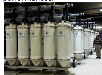
AVANT TRAVAUX : modules AC1125
