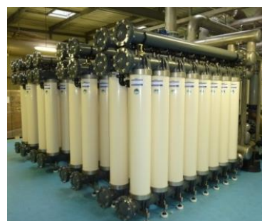
APRES TRAVAUX : modules ALTEON™
