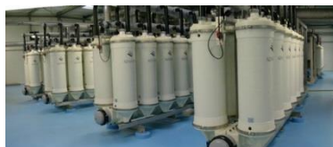
AVANT TRAVAUX : modules AC1125
