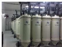
AVANT TRAVAUX : modules AC1125
