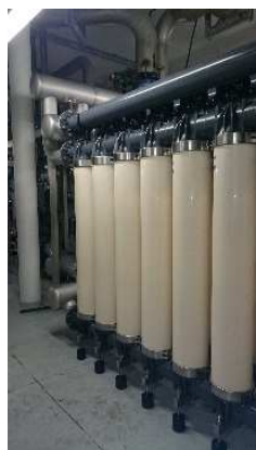
APRES TRAVAUX : modules Alteon™
