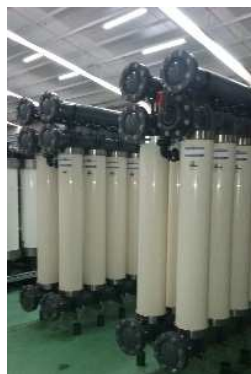
APRES TRAVAUX : modules Alteon™
