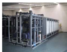
AVANT TRAVAUX : modules AC355
